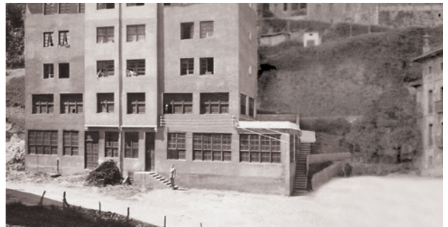
Construcción de un nuevo edificio de 3 plantas. Construction of a new building of 3 floors. Construction d'un nouveau bâtiment de 3 étages.
